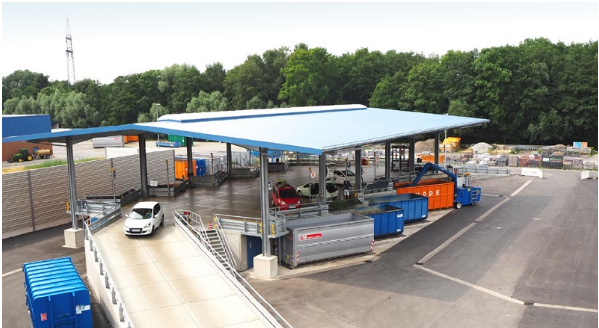
Abbildung 1: Modulo-Rampenanlage mit Überdachung
